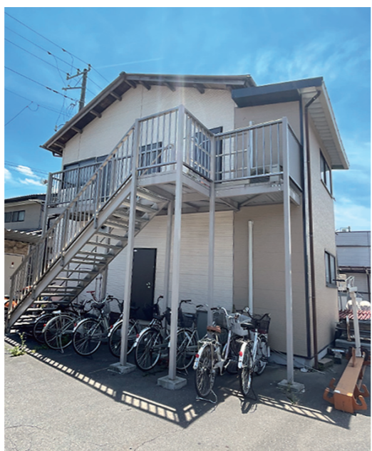
敷地内の社員寮に取り付けている屋外用鉄骨階段廊下ユニット「アパート」(上)、事務所に展示している室内鉄骨階段「アパートレジデンス」
